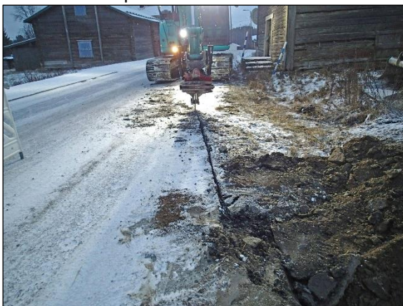
Oikealla: 18.12. kaivettua kaapeliojaa. Lapion kohdalle asti kaivettu määräsyvyyteen, lapiosta eteenpäin vain asfaltti ja sen alainen sora/hiekkakerros poistettu n. 50 cm syvyyteen, ehjän kulttuurikerroksen pintaan. Kuvattu lounaaseen.
