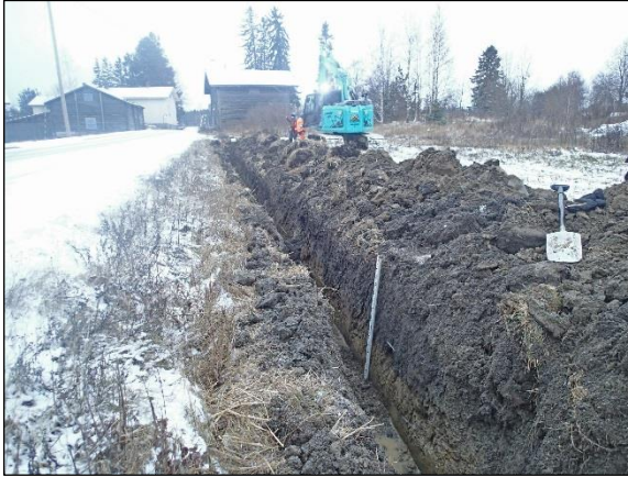
Kaapelikaivantoa Anian rantatien varrella, länsireunalla, valvotun osuuden pohjoisosassa, Kuvat etelään.
